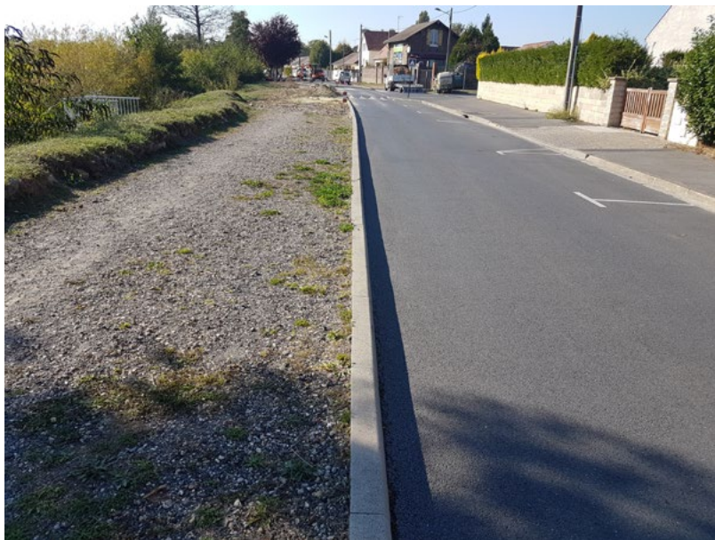
Ci-dessus, travaux 1 ère partie : pour exemple, voie de circulation côté rivière Oise et stationnement côté habitation
