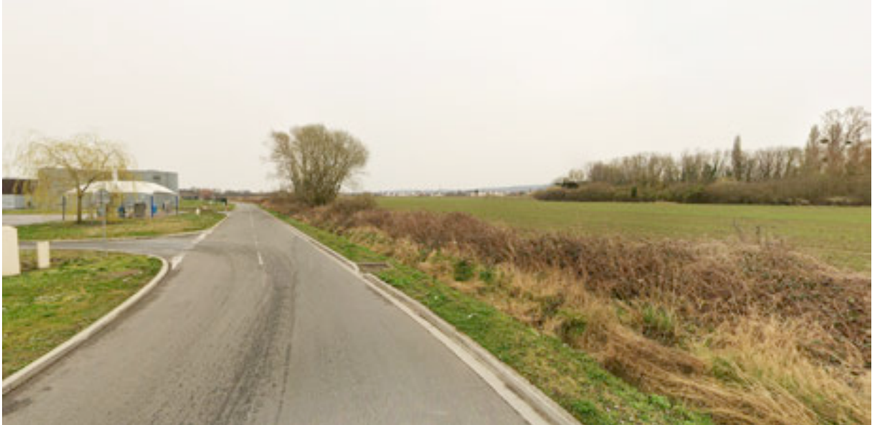
Vue sur la voie existante qui dessert l'emprise concernée par les OAP.
